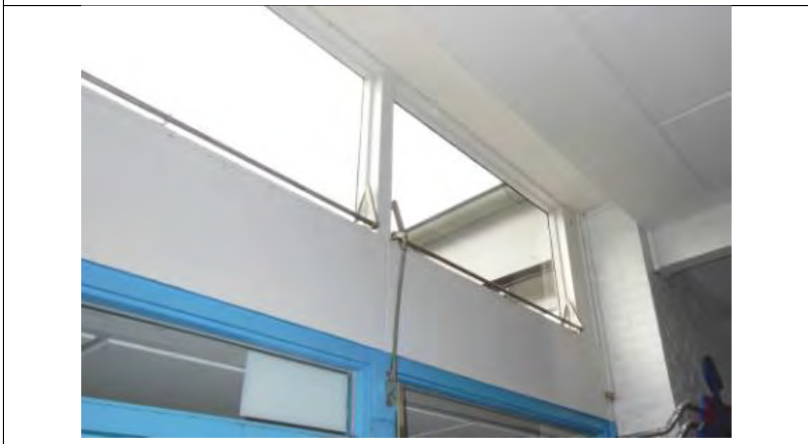
Undichte Oberlichter mit einfacher Verglasung
