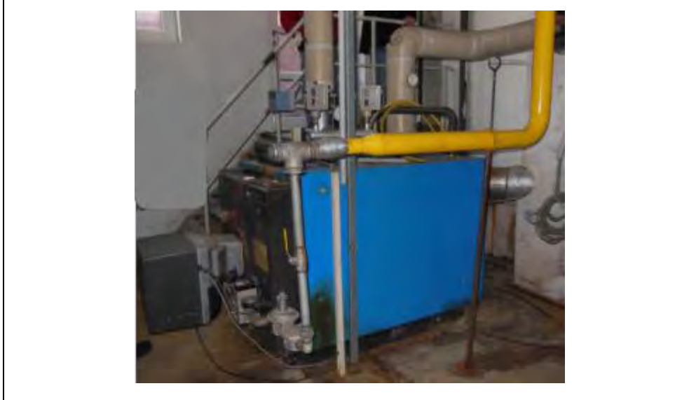
Weil der Brennwertkessel defekt ist, wurde er ausgebaut und der alte Gebläsekessel von 1981 wieder in Betrieb genommen.
